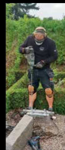
Huller bores i soklen
