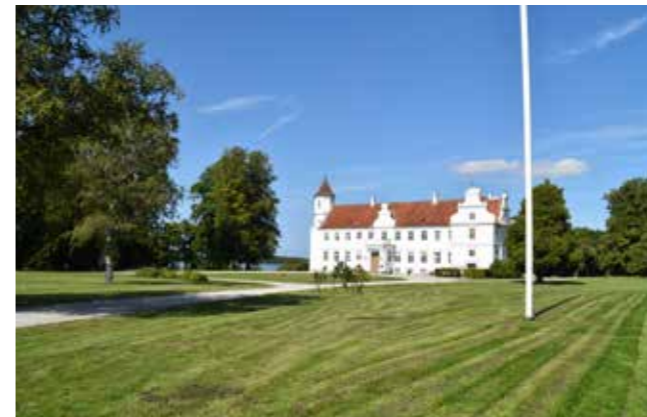
Barokhaven ved Søholt gods blev renoveret i perioden 2007-2010.
