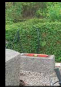
Opretning af soklen
